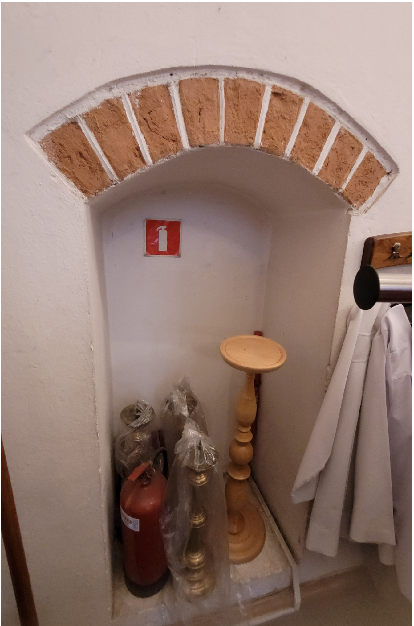
fot. 42. Kościół pw. Matki Bożej Częstochowskiej w Darłowie. Kaplica Grobowa. Zakrystia - wnęka w ścianie południowej zakrystii.
