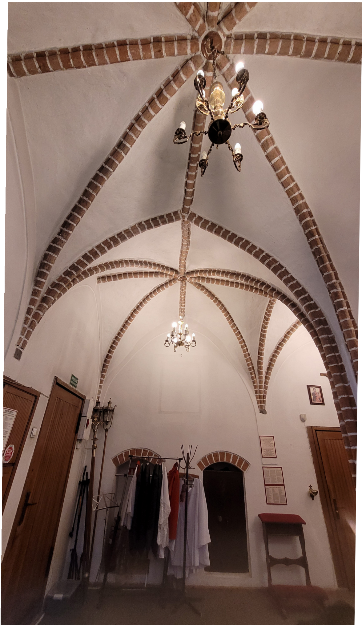
fot. 34. Kościół pw. Matki Bożej Częstochowskiej w Darłowie. Kaplica Grobowa. Zakrystia - sklepienie palmowe.
