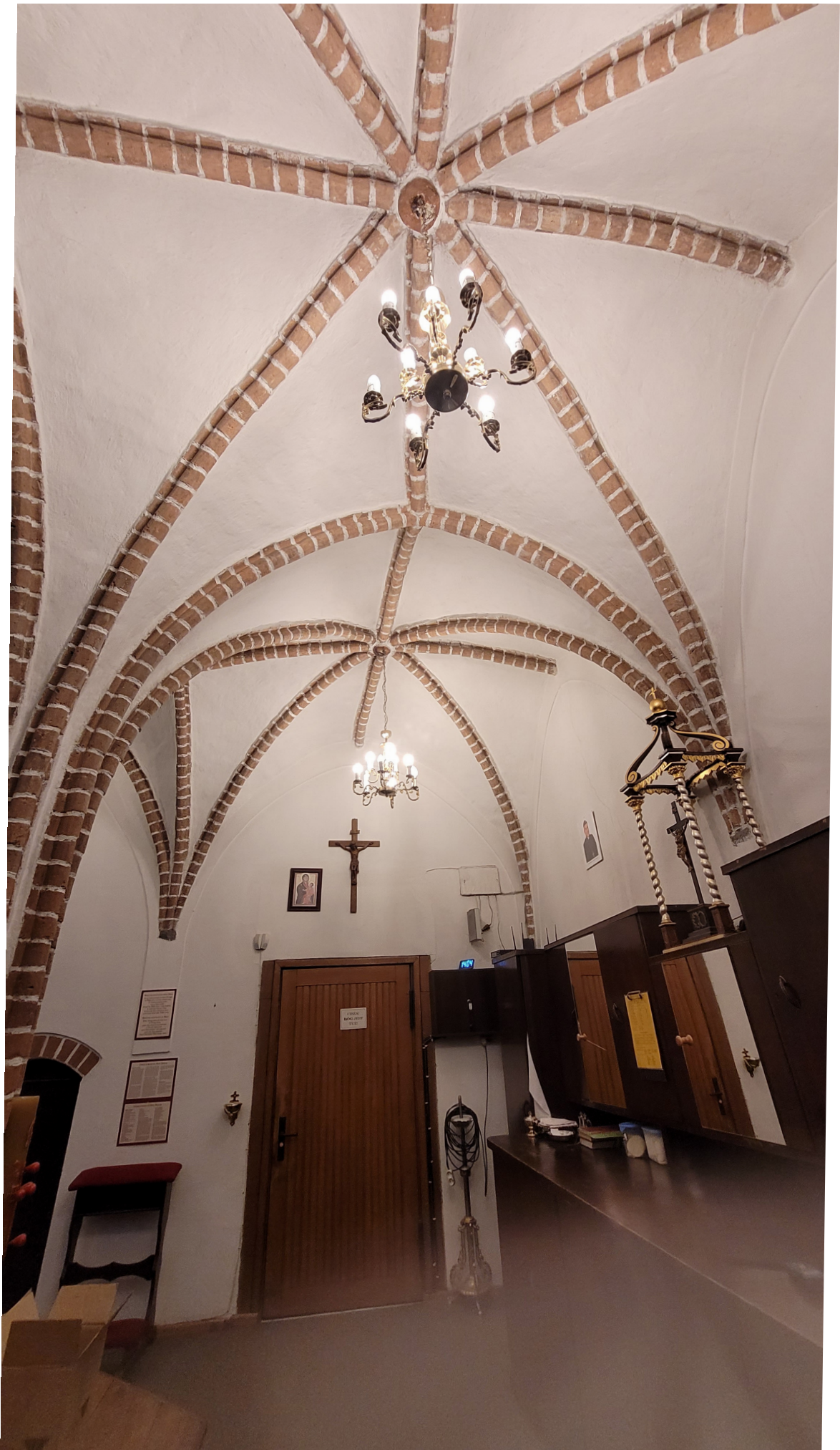
fot. 33. Kościół pw. Matki Bożej Częstochowskiej w Darłowie. Kaplica Grobowa. Zakrystia - sklepienie palmowe.
