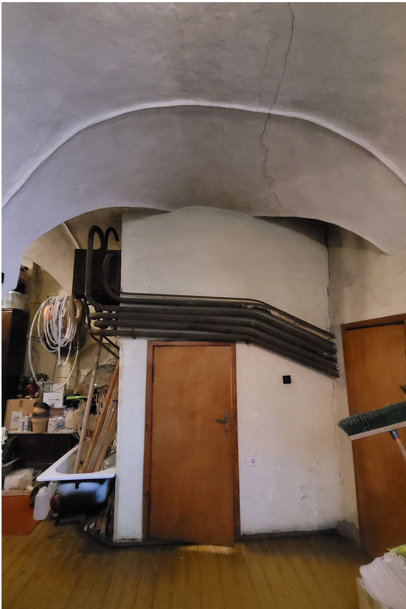
fot. 22. Kościół pw. Matki Bożej Częstochowskiej w Darłowie. Skarbczyk widok w kierunku zachodnim.
