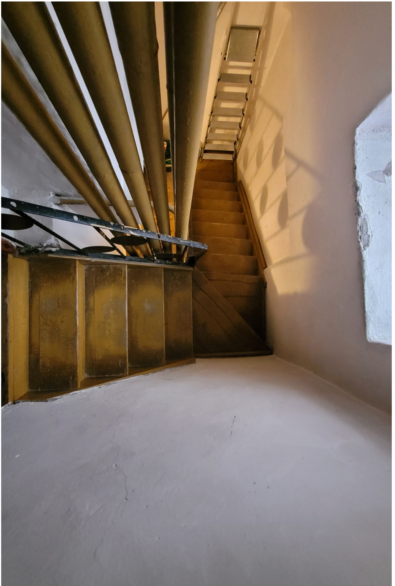
fot. 26. Kościół pw. Matki Bożej Częstochowskiej w Darłowie. Kaplica Grobowa. Klatka schodowa łącząca zakrystię ze skarbczykiem. Widok w kierunku północno - zachodnim.
