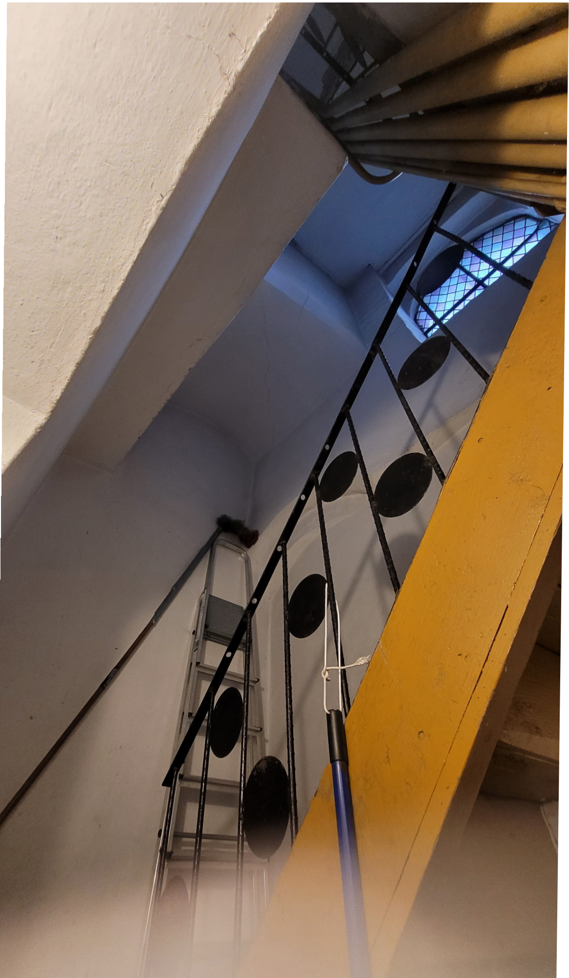
fot. 28. Kościół pw. Matki Bożej Częstochowskiej w Darłowie. Kaplica Grobowa. Klatka schodowa łącząca zakrystię ze skarbczykiem. Widok w kierunku północno - zachodnim.
