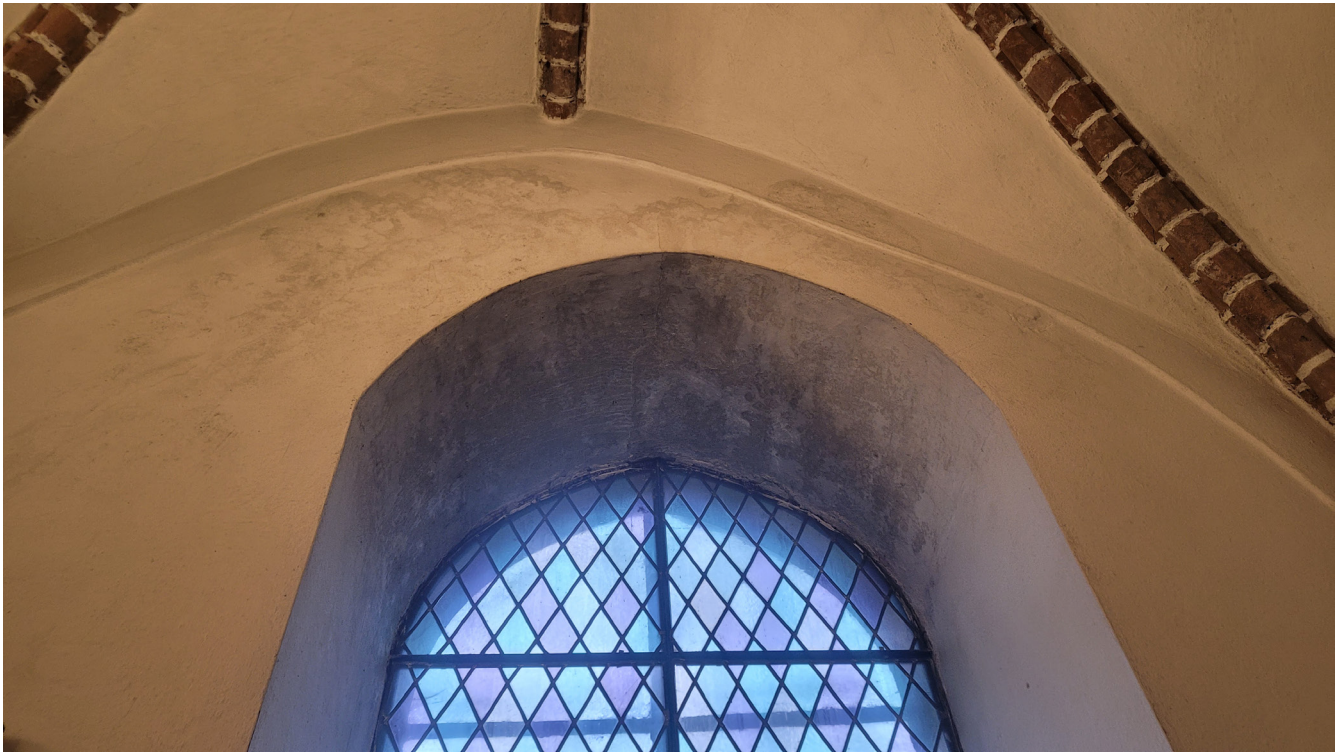
fot. 40. Kościół pw. Matki Bożej Częstochowskiej w Darłowie. Kaplica Grobowa. Zakrystia - zawilgocenie tynku przy glifie okiennym.
