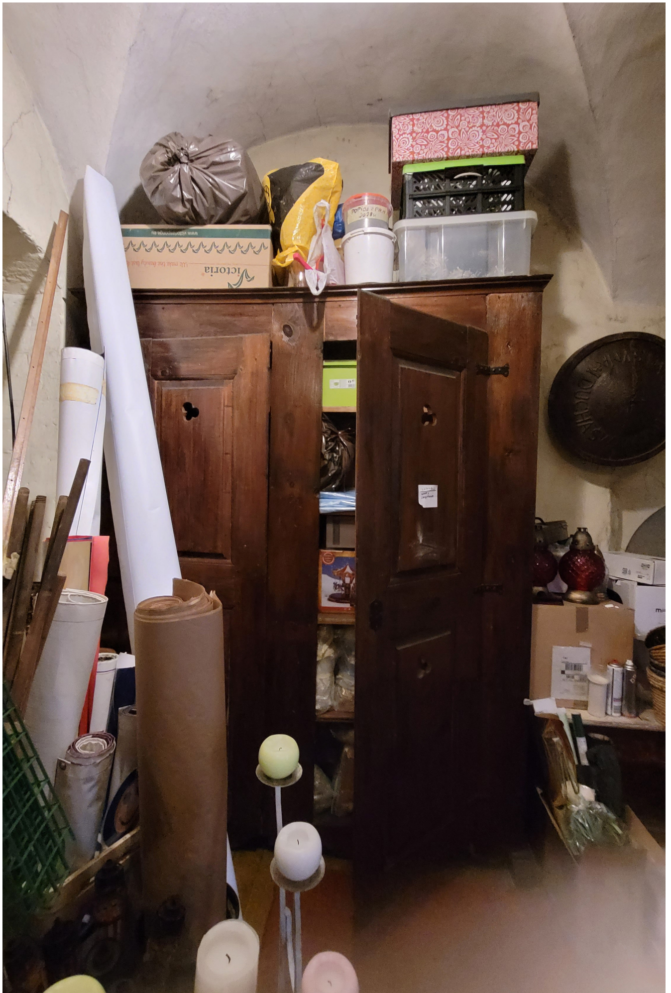
fot. 16. Kościół pw. Matki Bożej Częstochowskiej w Darłowie. Skarbczyk widok w kierunku południowo - zachodnim.
