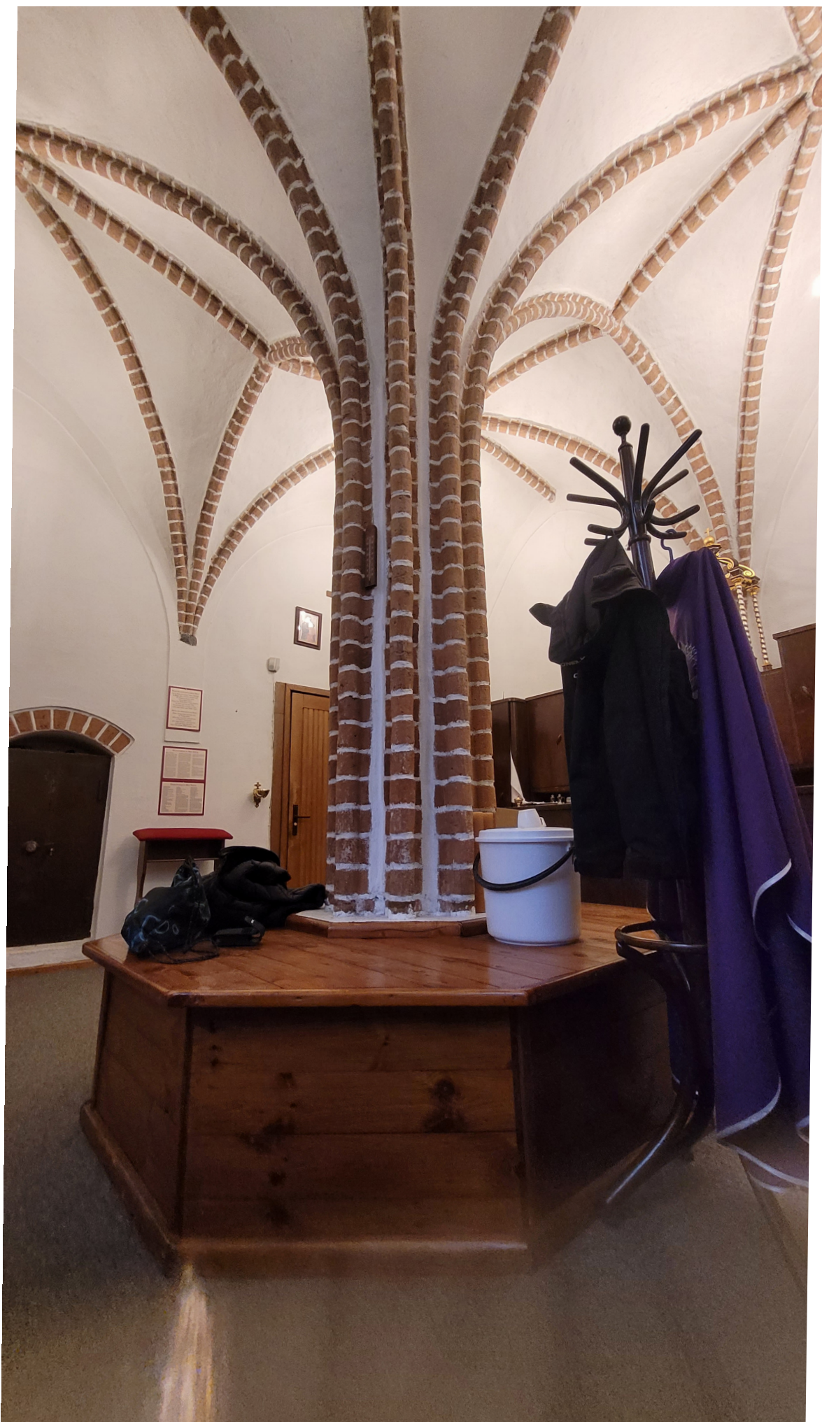
fot. 32. Kościół pw. Matki Bożej Częstochowskiej w Darłowie. Kaplica Grobowa. Zakrystia - słup sklepienia palmowego.
