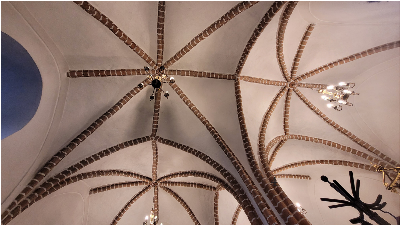
fot. 38. Kościół pw. Matki Bożej Częstochowskiej w Darłowie. Kaplica Grobowa. Zakrystia - sklepienie palmowe.
