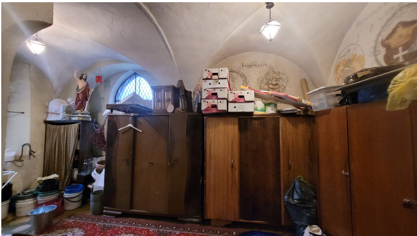
fot. 18. Kościół pw. Matki Bożej Częstochowskiej w Darłowie. Skarbczyk widok w kierunku północno - wschodnim.
