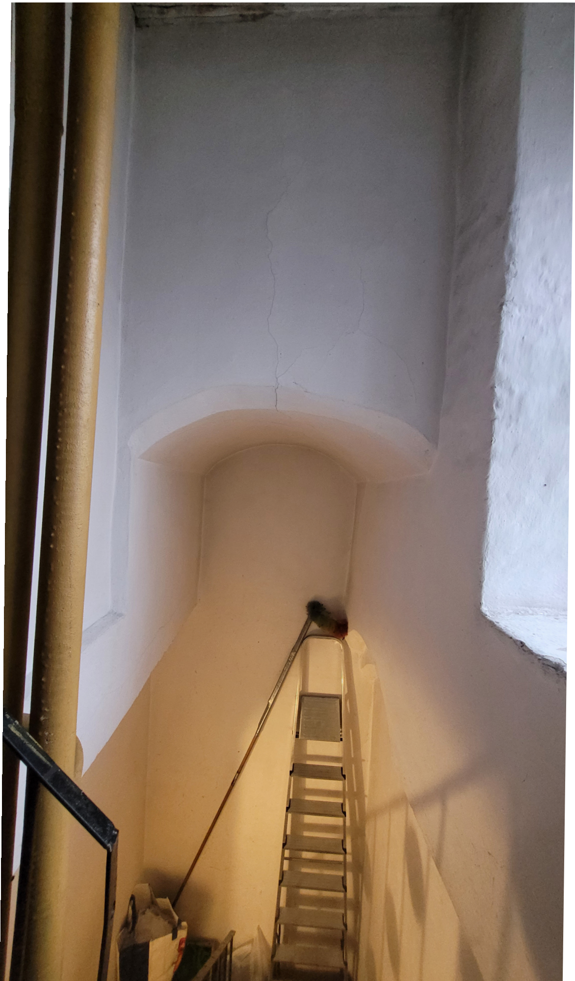
fot. 27. Kościół pw. Matki Bożej Częstochowskiej w Darłowie. Kaplica Grobowa. Klatka schodowa łącząca zakrystię ze skarbczykiem. Widok w kierunku zachodnim.
