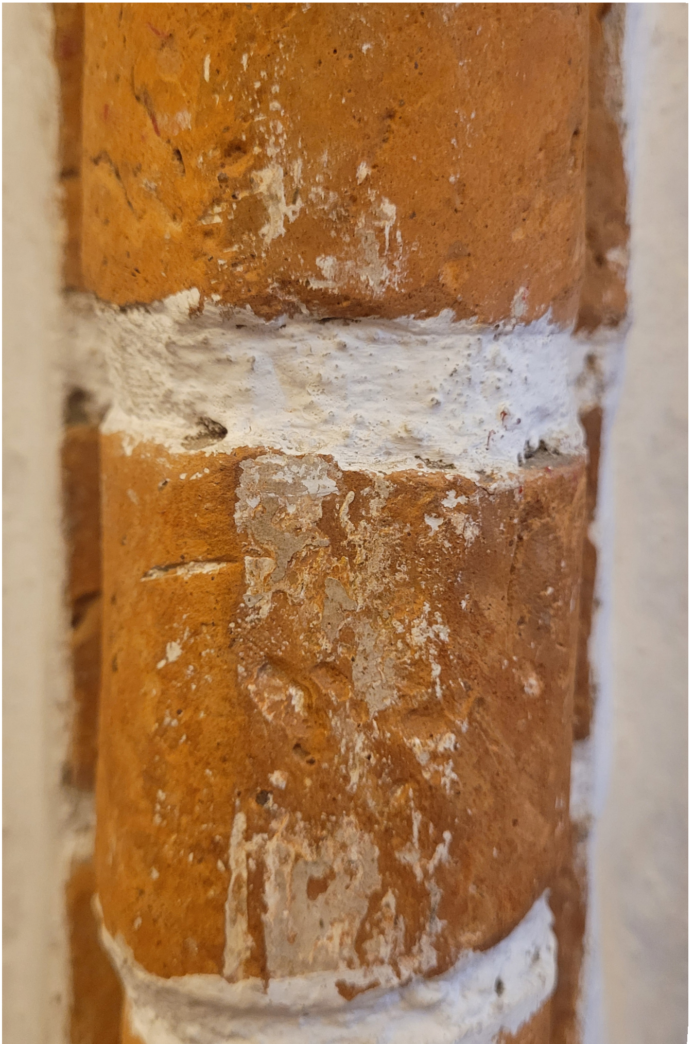
fot. 46. Kościół pw. Matki Bożej Częstochowskiej w Darłowie. Widoczne relikty polichromii znajdujące się na słupie sklepienia palmowego.
