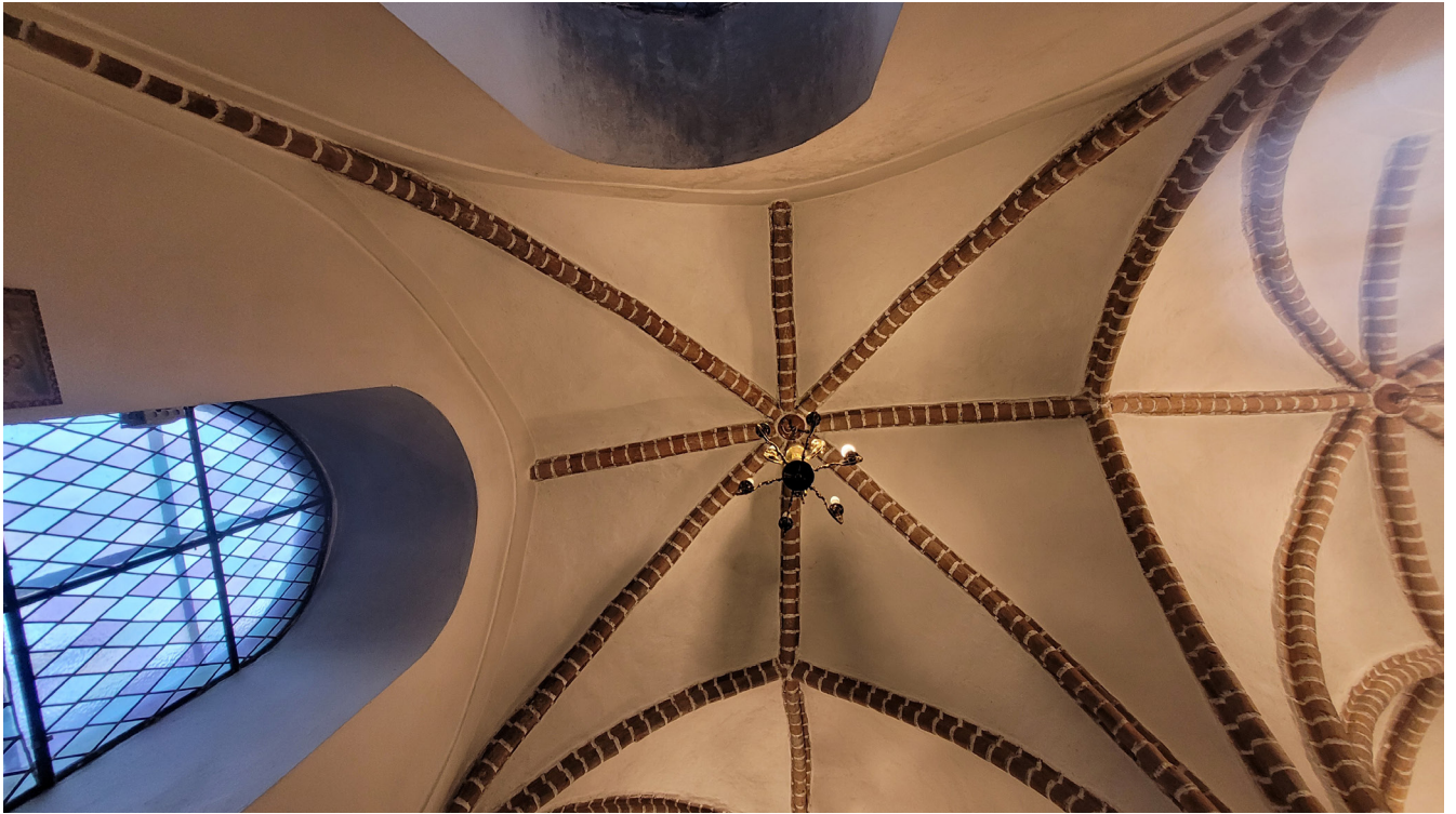
fot. 37. Kościół pw. Matki Bożej Częstochowskiej w Darłowie. Kaplica Grobowa. Zakrystia - sklepienie palmowe.
