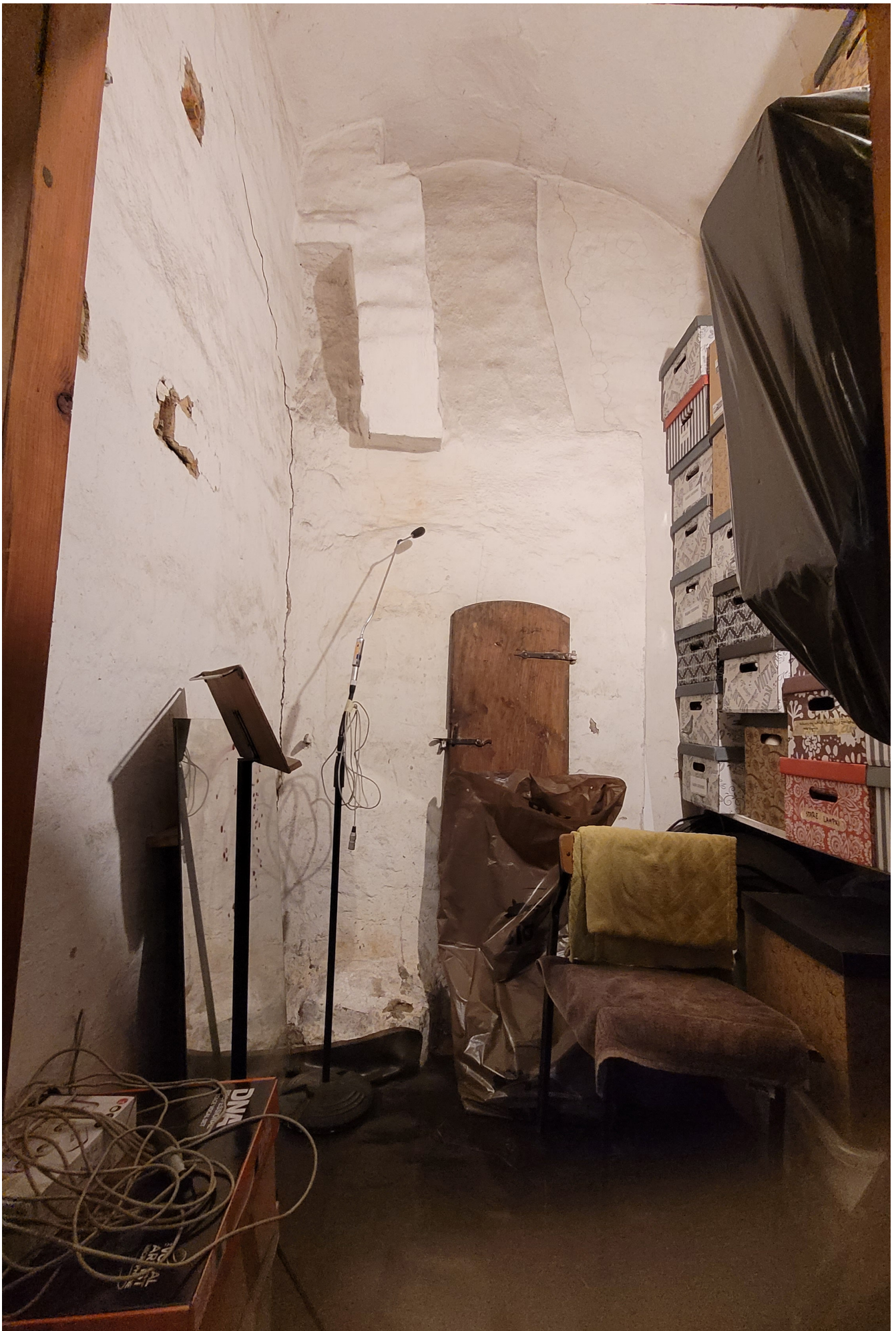
fot. 23. Kościół pw. Matki Bożej Częstochowskiej w Darłowie. Skarbczyk widok w kierunku zachodnim - komin.
