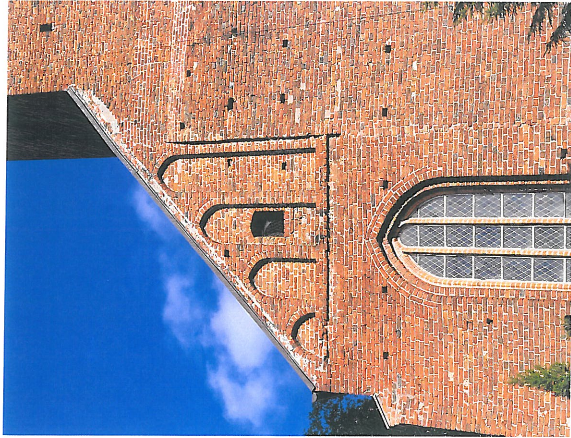
Fot. 3. Darłowo – kościół pw. Matki Bożej Częstochowskiej, elewacja zachodnia. Na południe (strona prawa) od okna północnej kaplicy przywieżowej z XVI/XVII w. pionowy ślad po jej dostawieniu do wieży.
