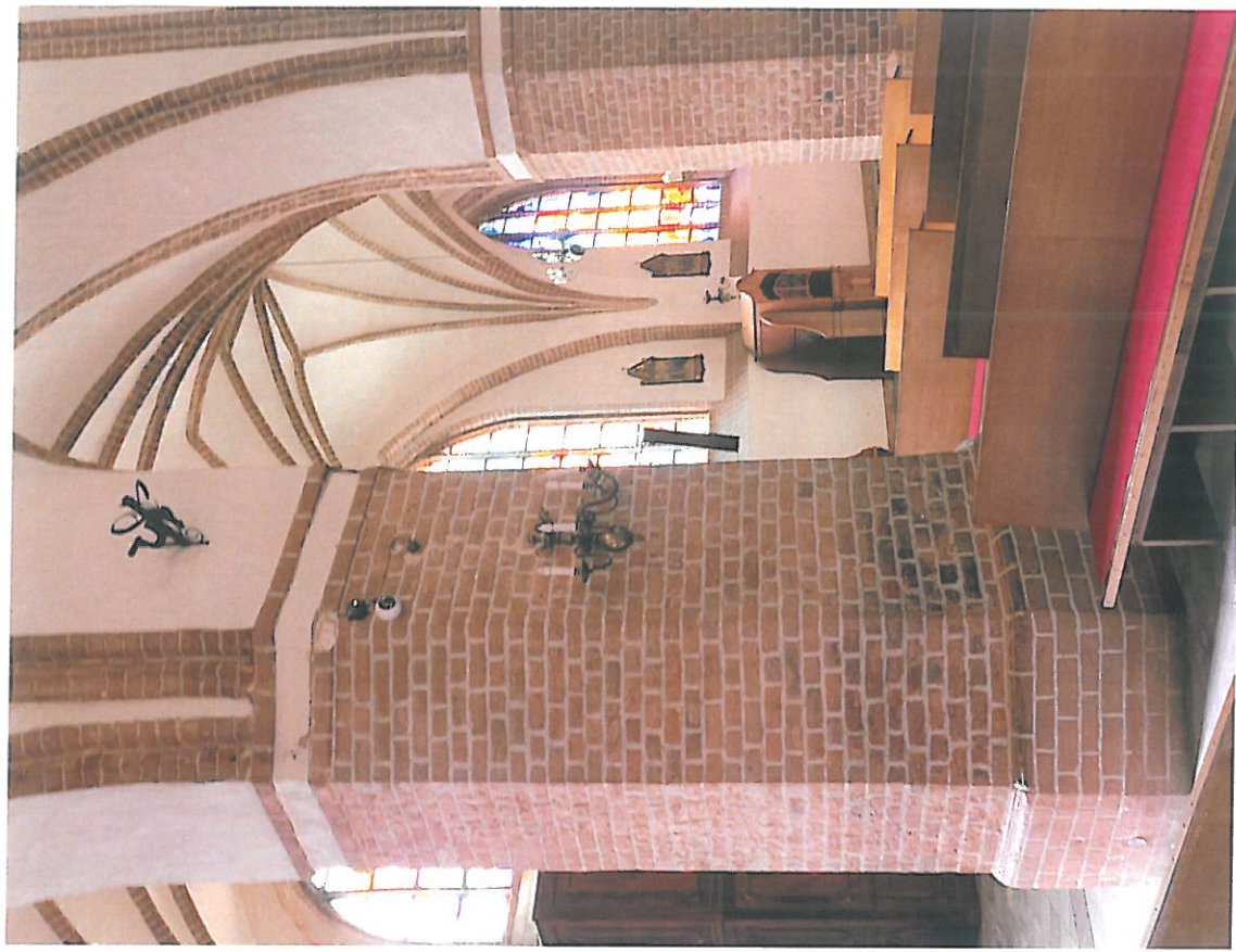
Fot. 16. Darłowo – kościół pw. Matki Bożej Częstochowskiej, filar nawy południowej. Jego nieforemny trzon nie ma zdobień zaś baza z profilowaniem jest jednoskokowa.
