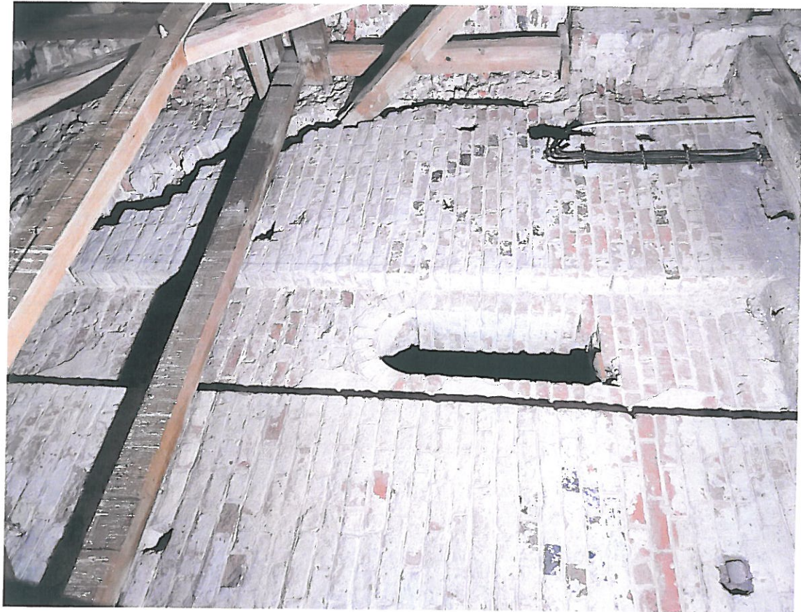
Fot. 23. Darłowo – kościół pw. Matki Bożej Częstochowskiej, poddasze kaplicy wschodniej. Ściana należąca do nawy południowej zawiera ostrołuczne wnęki będące dekoracją architektoniczną jej szczytu przed dobudowaniem kaplicy.
