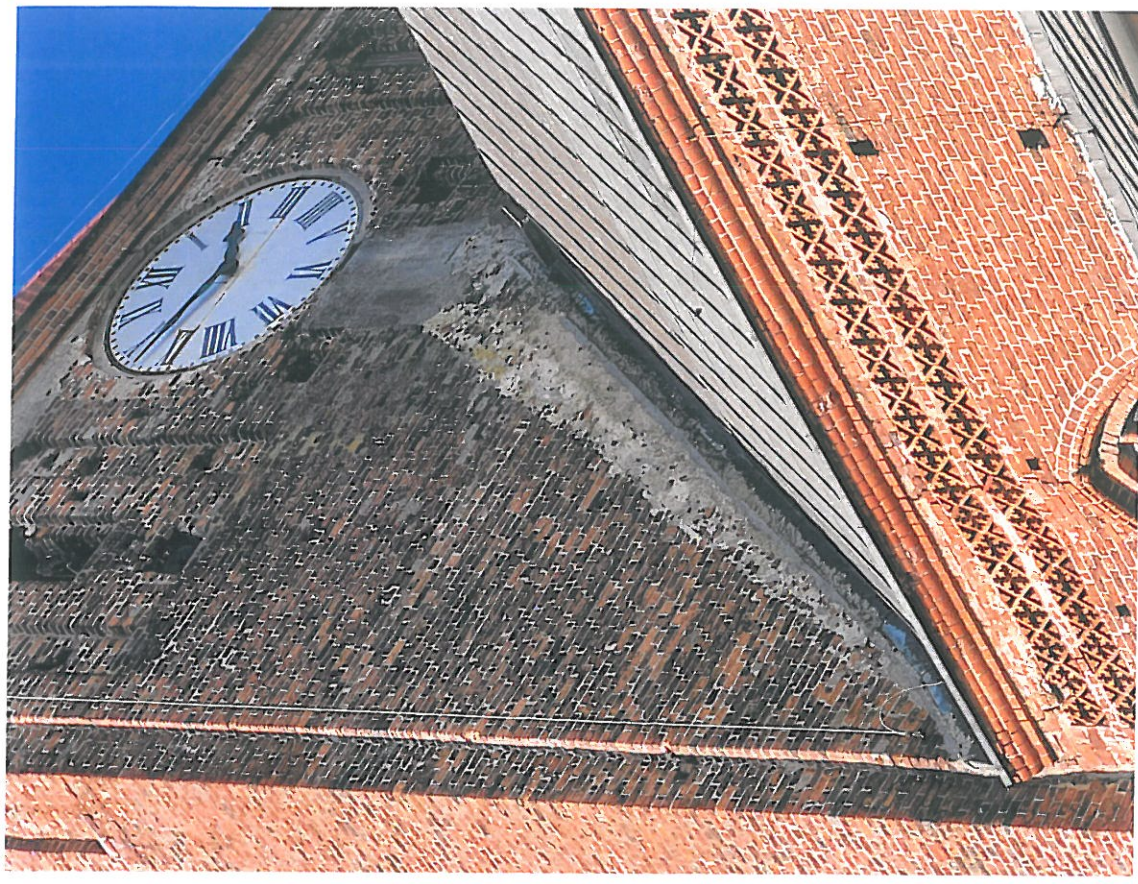
Fot. 14. Darłowo – kościół pw. Matki Bożej Częstochowskiej. Widok od strony południowej na ścianę wschodnią wieży ze śladami po wcześniejszym, średniowiecznym dachu nawy głównej.
