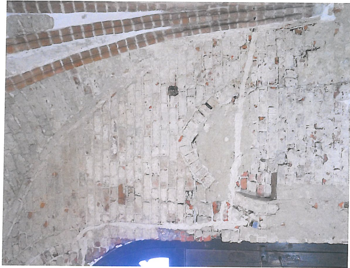
Fot. 21. Darłowo – kościół pw. Matki Bożej Częstochowskiej, wnętrze kaplicy wschodniej. Na zachód (po prawej stronie) od obecnego wejścia znalezione zostały ostrołuczny łęk i dochodzące do niego pionowe fugi – pozostałości po pierwszym wejściu z zewnątrz do kaplicy. Powyżej działającego wejścia – fragment łęku po średniowiecznym oknie.
