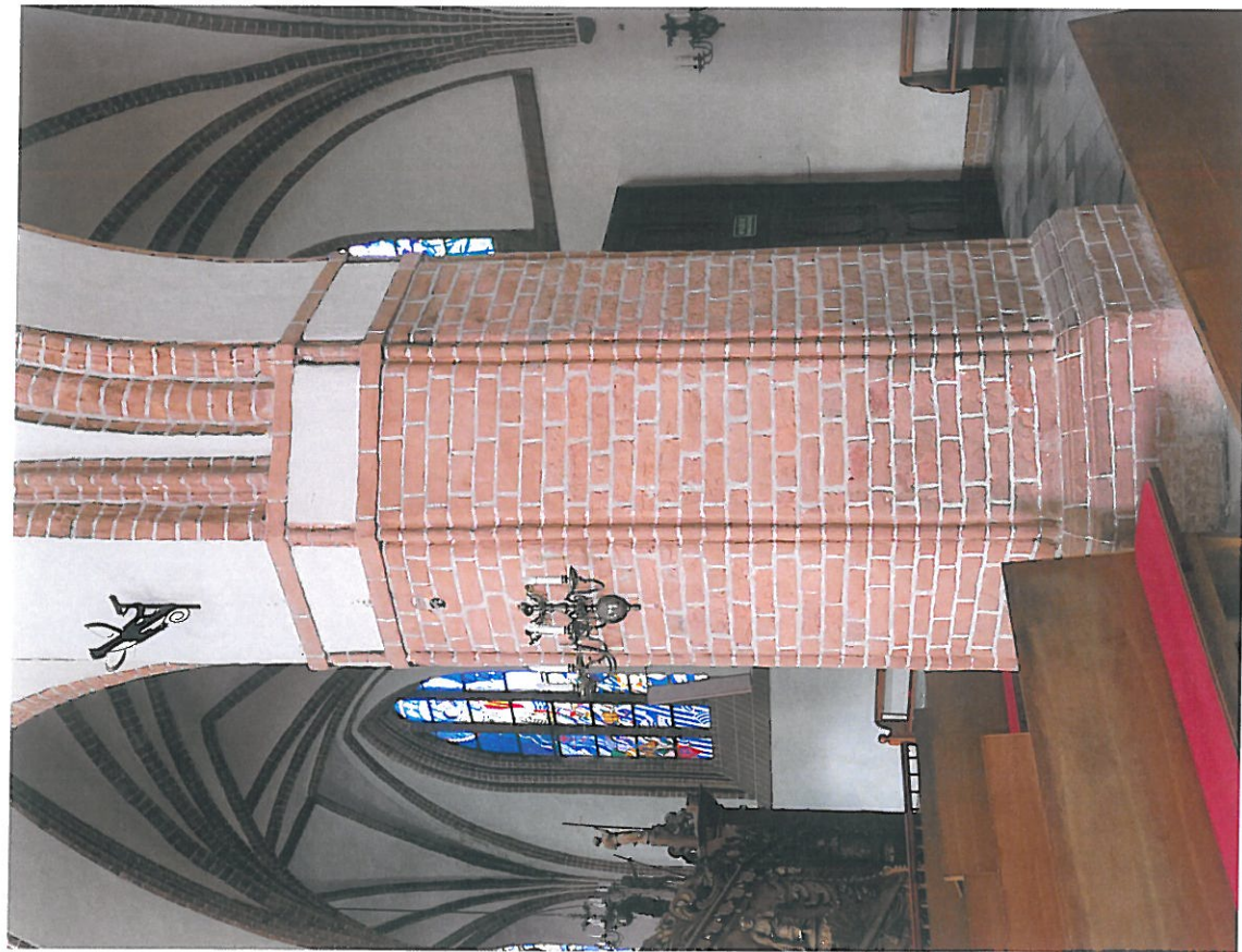
Fot. 15. Darłowo – kościół pw. Matki Bożej Częstochowskiej, filar nawy północnej. Jest on foremny, zawierający w narożach cegły kształtki i dwuskokową profilowaną bazę.
