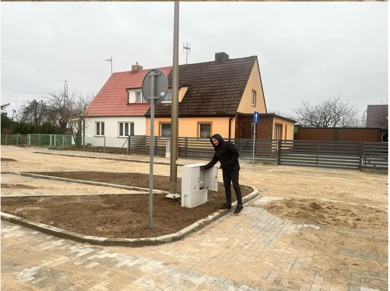
Na zdjęciu: fragment ulicy, nawierzchnia w trakcie tzw. zamulenia kostki betonowej
